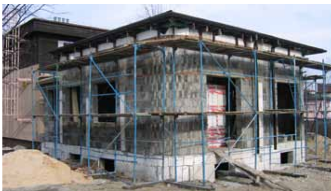
Budowa nowej sali konferencyjnej (06.03.2007 r.)
